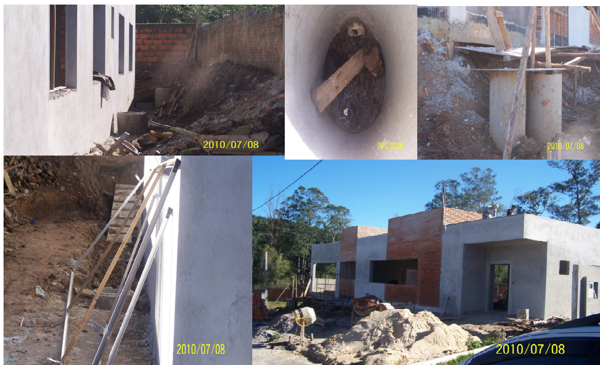
Figura 6.6 - Estudo de Caso – III – Em construção
