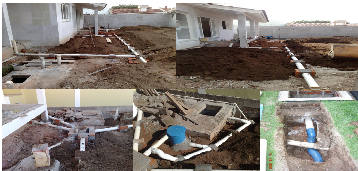
Figura 6.4 - Estudo de Caso – II – em construção.
