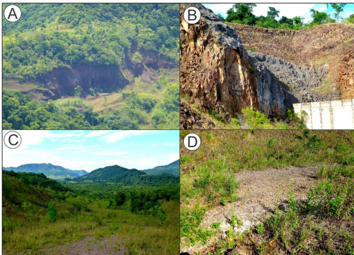
Figura 24 - Área utilizada como pedra (A); Cobertura de concreto utilizada na ombreira esquerda para contenção da erosão (B); Vias de acesso (C); Concreto presente na área (D).
