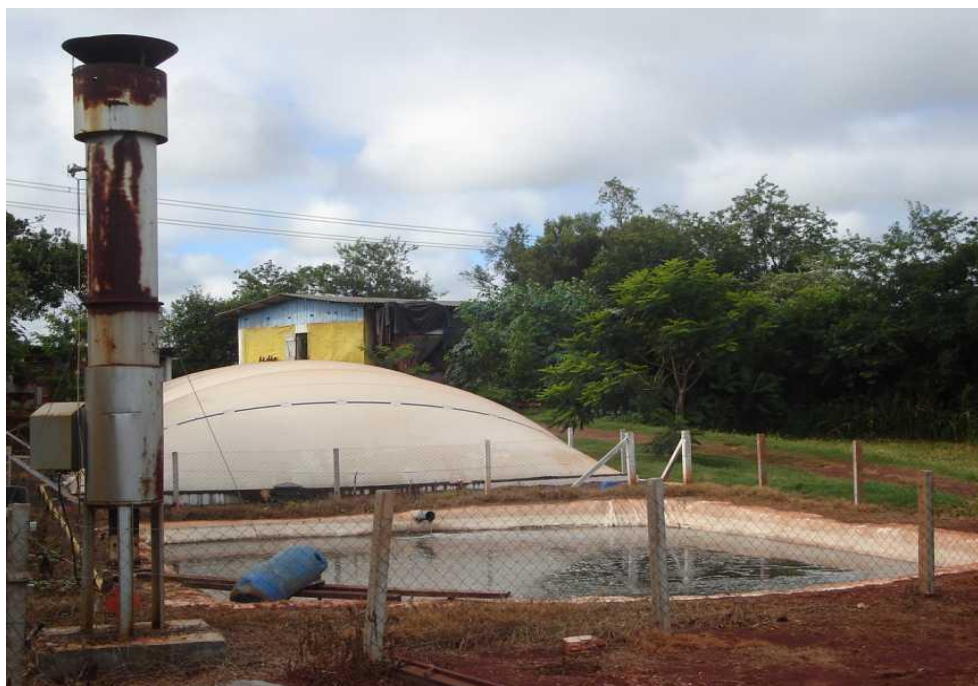
Figura 4 – Sistema completo: biodigestor, depósito, medidor e queimador
