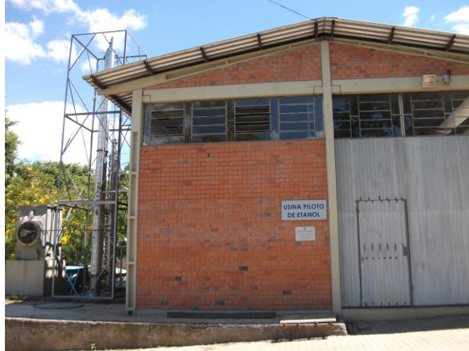
Figura 4.2 – Vista externa da usina piloto de etanol
