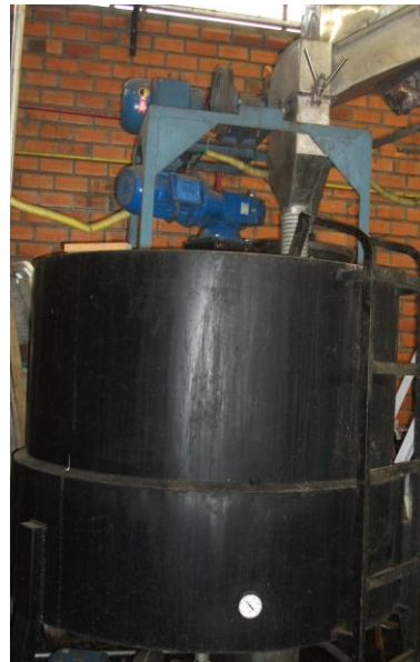
Figura 4.6 – Vista externa do tanque de hidrólise
