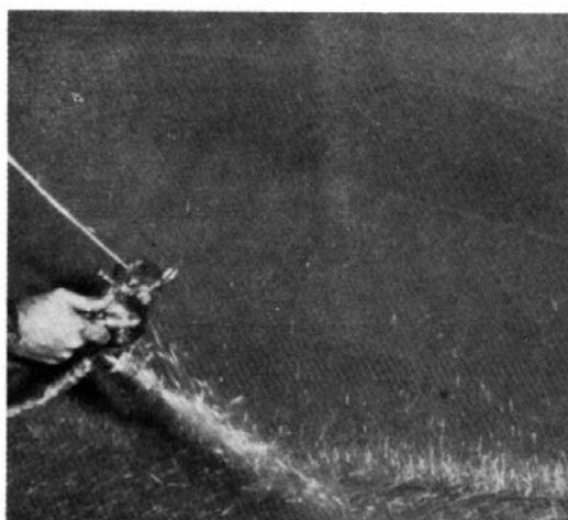
Moldagem por pulverização de um bote salva-vidas utilizando resina CRYSTIC
