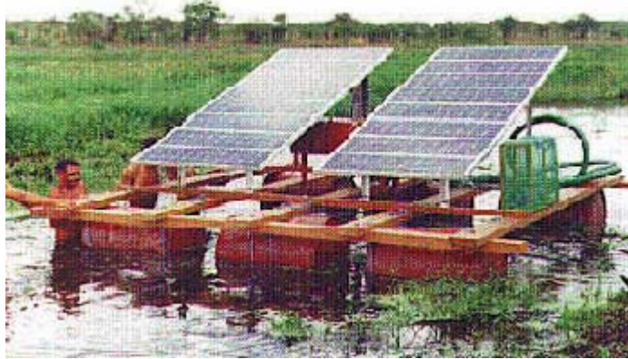
Figura 15 - Sistema de bombeamento de água suprido por energia solar fotovoltaica. Fonte: Atlas de Energia Elétrica do Brasil.
