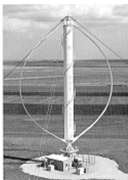
Figura 2-16. Turbina eólica de eixo vertical do tipo Darrieus [6].
