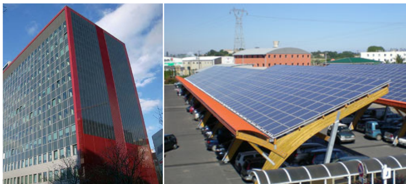
Figura 1.4 – Integração dos painéis fotovoltaicos em construções [7].
