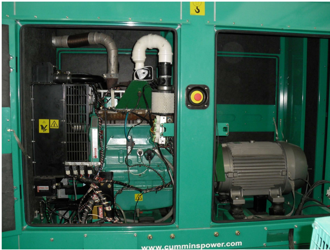
Figura 3.17 – Motor de combustão interna ciclo otto e gerador síncrono de ímãs permanentes instalados no NAFA/UFSM
