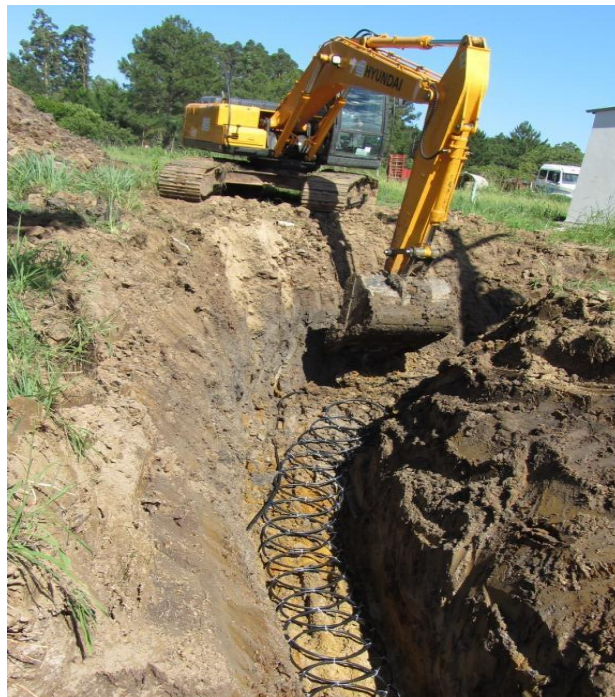
Figura 5.13 - Detalhe da mangueira enterrada a 3,5 metros de profundidade
