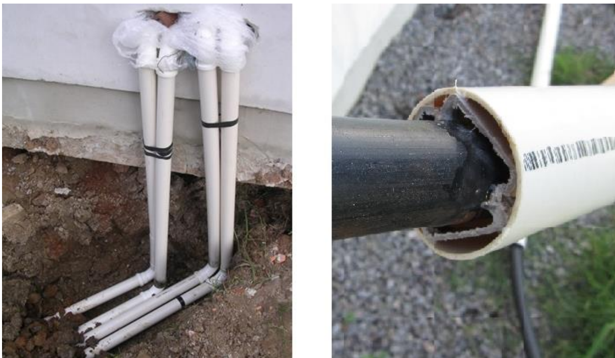
Figura 5.14 - Detalhe da entrada das mangueiras e isolamento térmico em PVC
