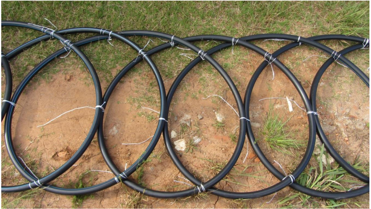
Figura 5.15 - Detalhe da amarração das espiras das mangueiras
