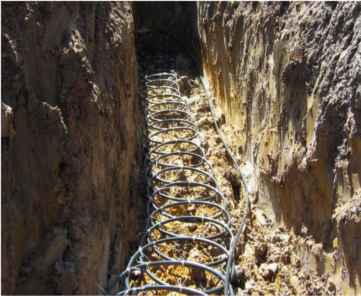
Figura 5.12 - Detalhe da mangueira enterrada a 5 metros de profundidade
