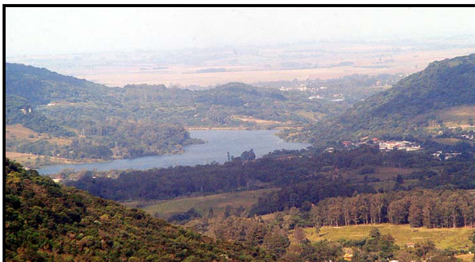
Figura 1 – Barragem do Departamento Nacional de Obras e Sanidade – DNOS. Santa Maria, RS. (Fonte: Guerra, 2004).
