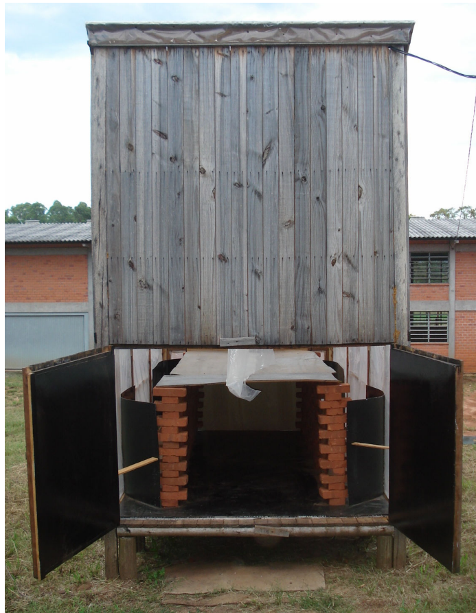
Figura 4 – Parede Sul e parte interna da estufa solar.
