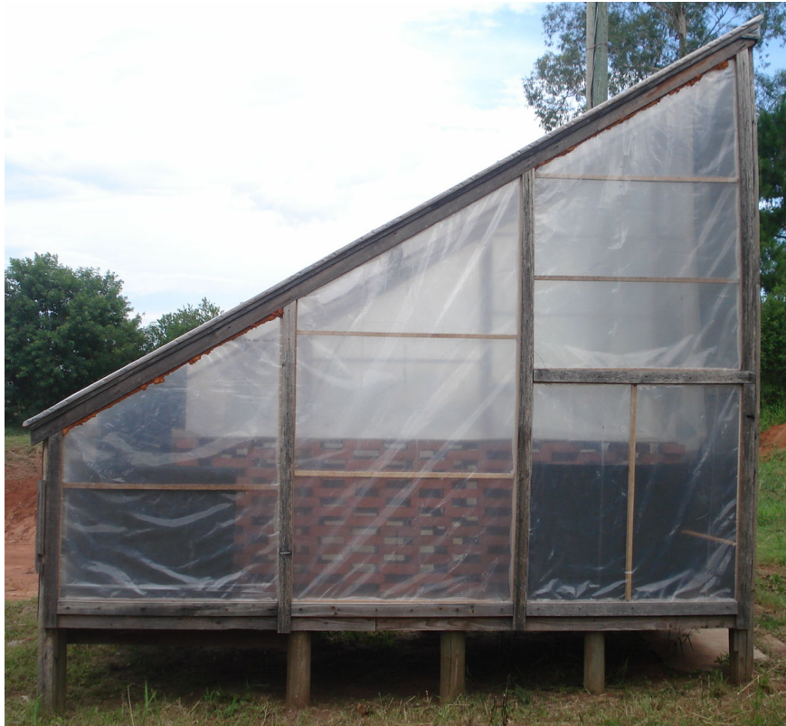
Figura 6 – Parede Oeste e a parede vazada de tijolo.
