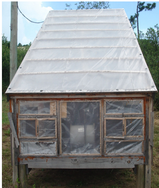
Figura 5 – Parede Norte e as janelas para renovação do ar da estufa solar.
