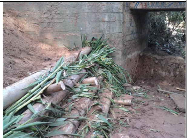
Vista da parede à jusante do arroio Cancela, junto a ponte de entrada do parque.
