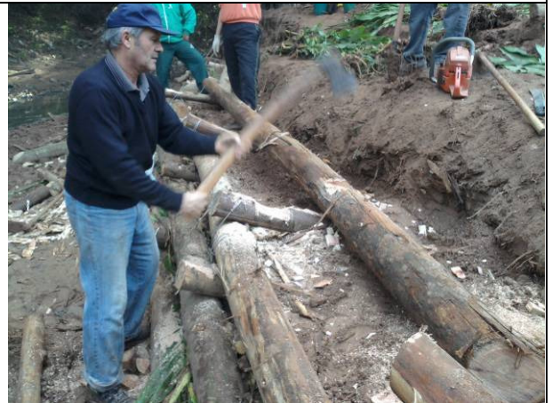
Peças transversais e longarinas falquejadas para facilitar o encaixe.
