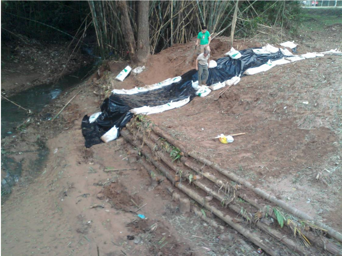
Figura 16 – Valeta coberta com lona plástica emergencial de 12 x 4 metros.
