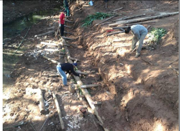
Peças transversais preparadas para a colocação da terceira linha de longarinas.
