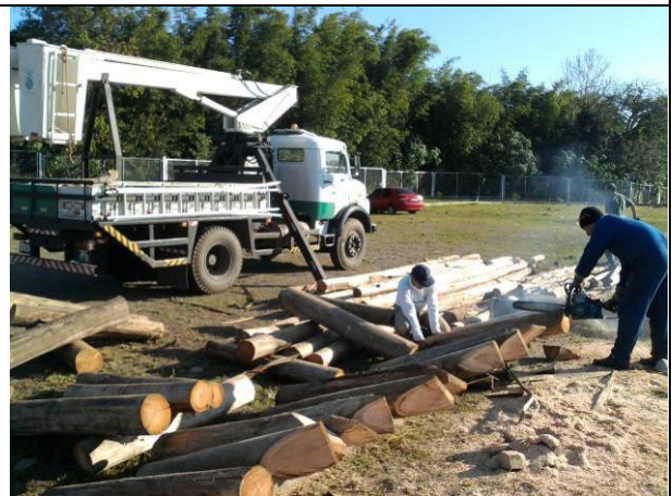
Pilotos falquejados com motosserra. Feito isso, foram transportados no caminhão.
