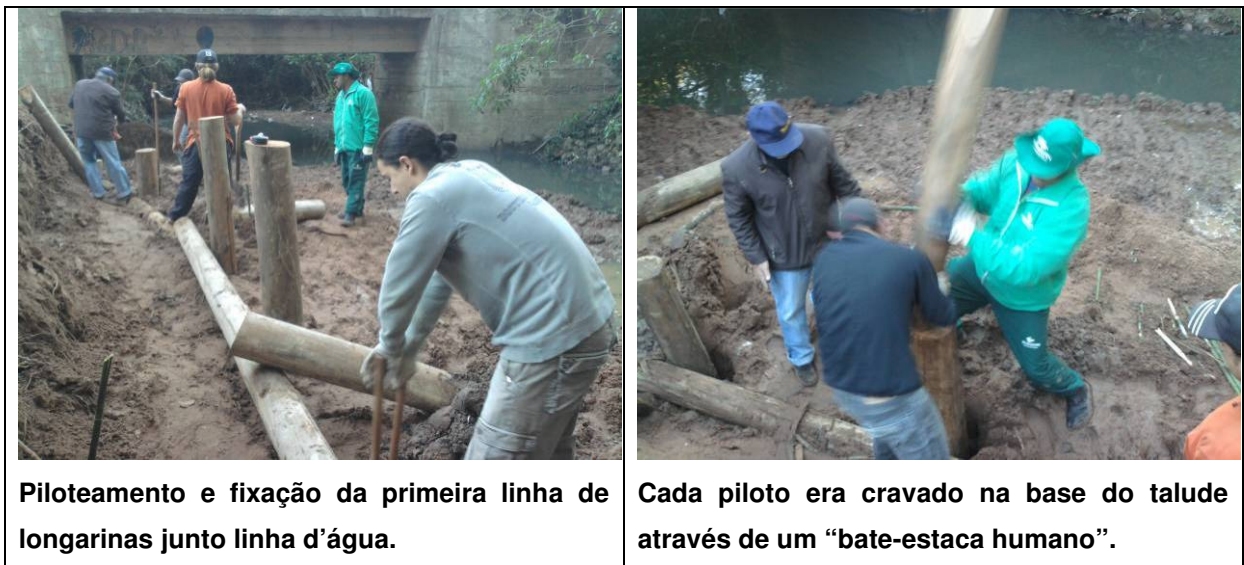
Quadro 8 – Piloteamento e primeira linha de longarinas.
