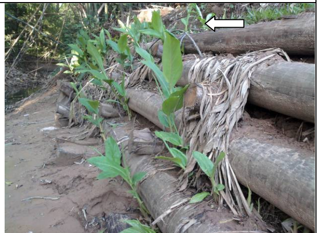
Observa-se algumas brotações do T3 a partir da 5ª longarina, junto ao talude.
