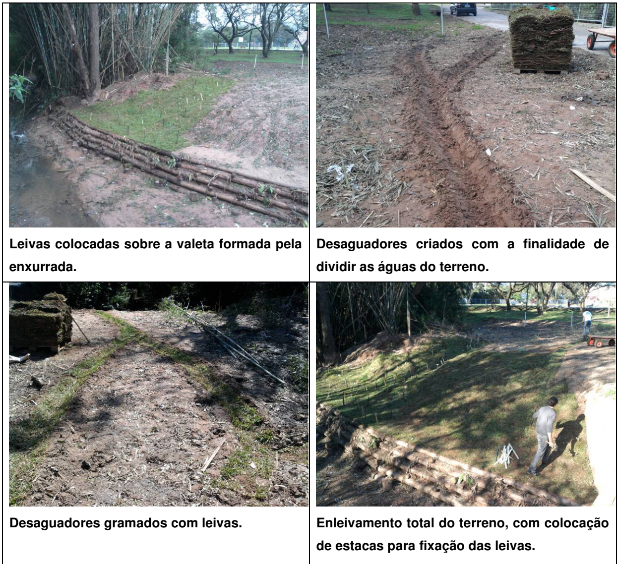
Quadro 10 – Enleivamento do terreno para correção do processo erosivo.
