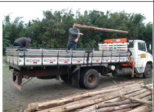
Baldeio da madeira no local da obra (parque da CACISM).
