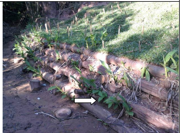
Observa-se as brotações do T2 entre a 2ª e a 3ª longarinas da Parede Krainer.
