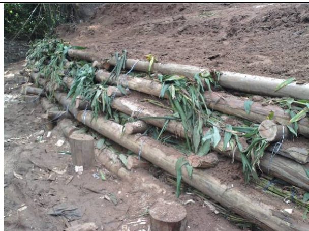
Vista à montante da parede Krainer (simples) compostas por 5 linhas de longarinas.
