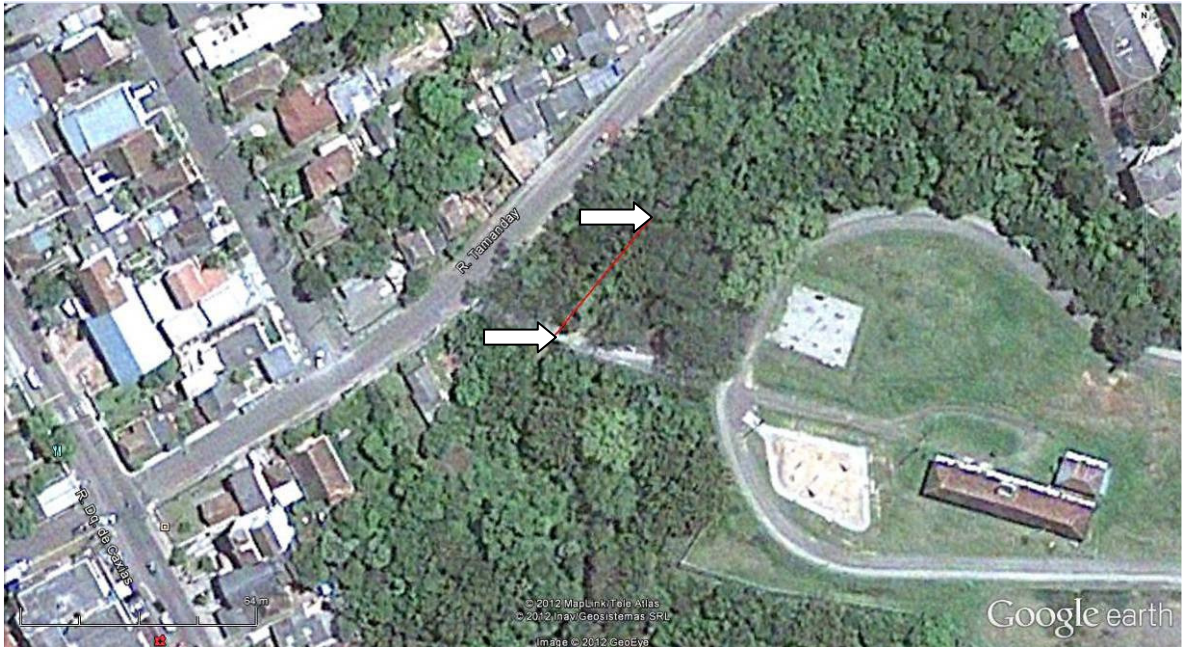
Figura 2 – Vista superior do trecho do curso de água a ser tratado.
