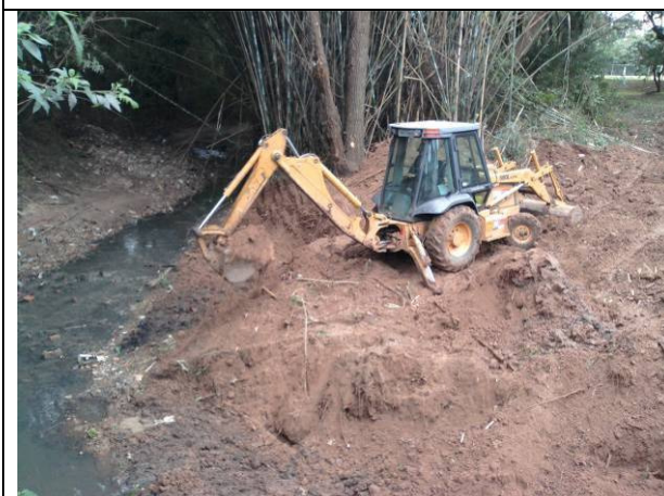
Remodelagem do talude e retirada de material.
