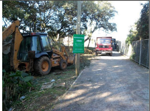
Carregamento das touceiras, galhos e entulho, realizado por outra retroescavadeira.
