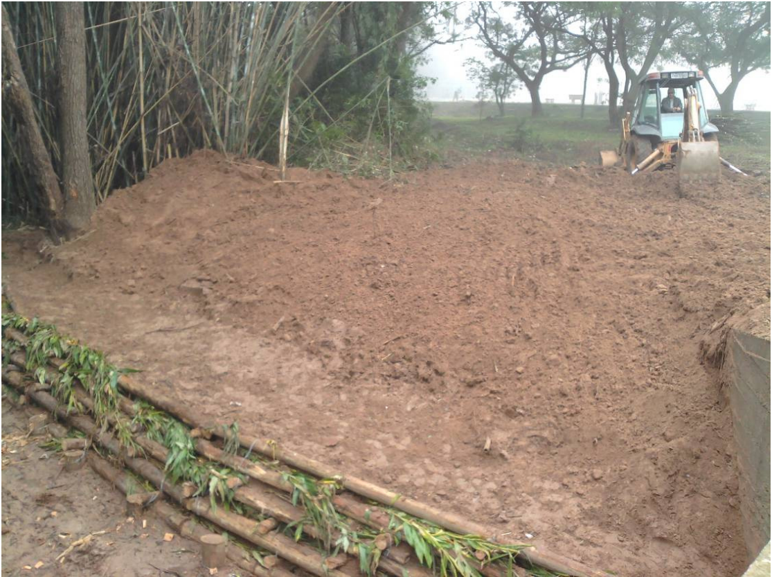
Figura 15 – Terraplanagem do terreno.
