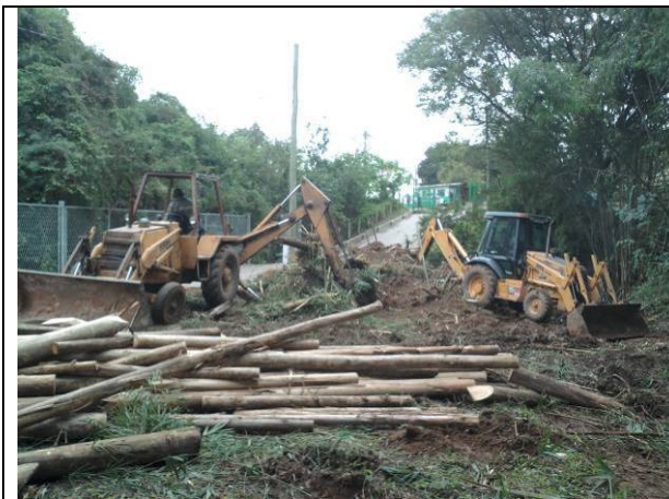
Retroescavadeiras removendo entulho.
