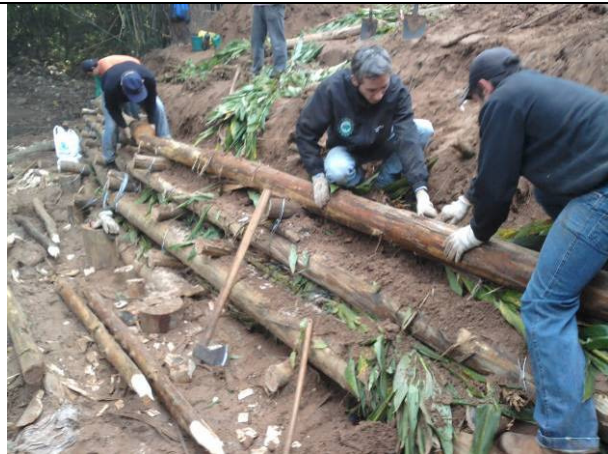
Preenchimento da estrutura com os feixes de cardamomo nas gavetas.
