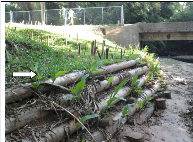
O tratamento Alto do talude obteve a média de 1,07 brotações por metro linear.
