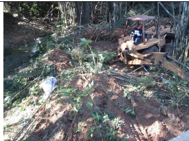
Retroescavadeira retirando as touceiras das taquaras e reconstituindo o talude.
