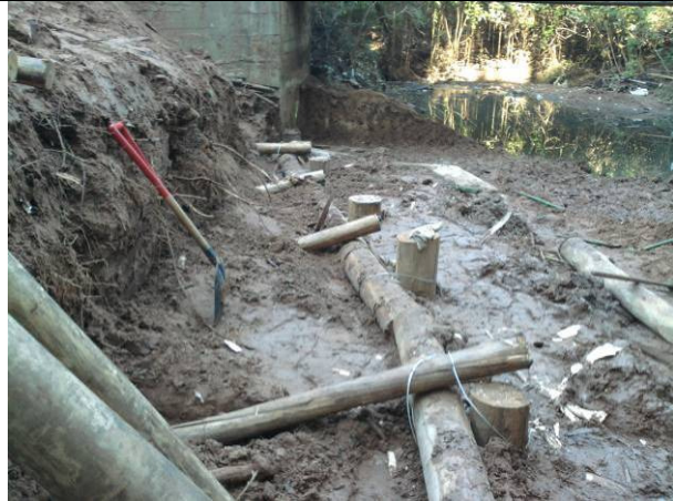
Piloteamento concluído e primeira linha de longarinas fixada com as peças transversais.
