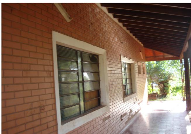
**Figura 10** – Janela com vidros quebrados na ALAT Yby Yau, Concepción. O conserto tem de ser feito pelos próprios extensionistas.
