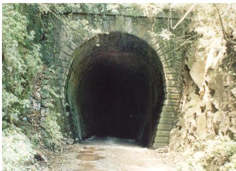
Foto 3. Entrada do Túnel de Linha Bonita
