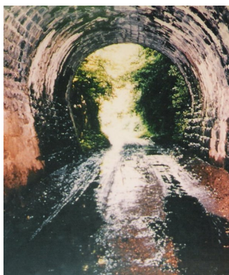
Foto 2. Túnel de Linha Bonita construído em 1906, com 93 m de comprimento, 5,7 m de altura e 4,10 m de largura.
