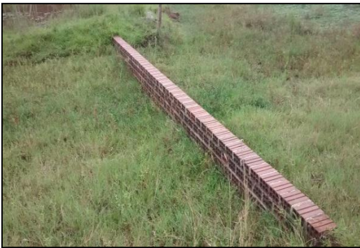
Figura 7 - Taipa de tijolos
