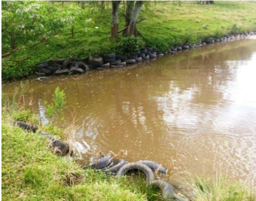
Figura 5 - Taipa protegida com pneus
