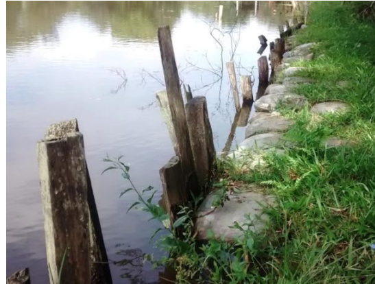
Figura 6 - Taipa protegida com sacos de barro
