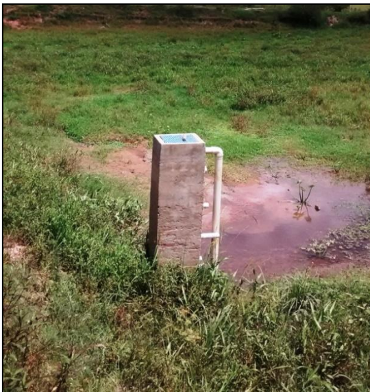
Figura 10 - Monge adaptado com canos. individual
