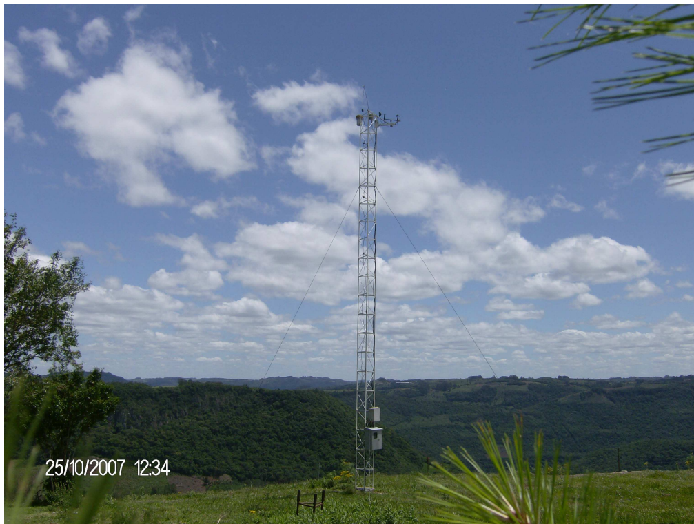
Figura 4.1: Foto da estação São Roque (Nova Roma do Sul), localizada em uma propriedade particular.
