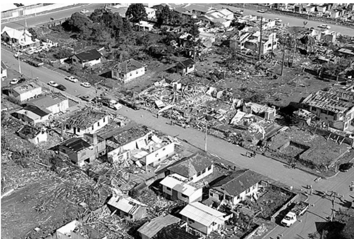
Figura 6.11 - Moradias destruídas e destelhadas pelo tornado que atingiu o município de São Francisco de Paula em julho de 2003.
