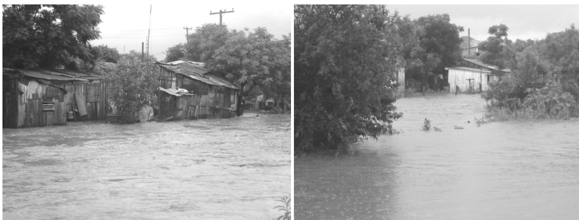
Figuras 6.7 e 6.8 - Moradias atingidas pela enxurrada no município de Santo Ângelo em dezembro de 2003. Fonte: Defesa Civil do Estado do Rio Grande do Sul. Disponível em: < http://www.defesacivil.rs.gov.br >.
