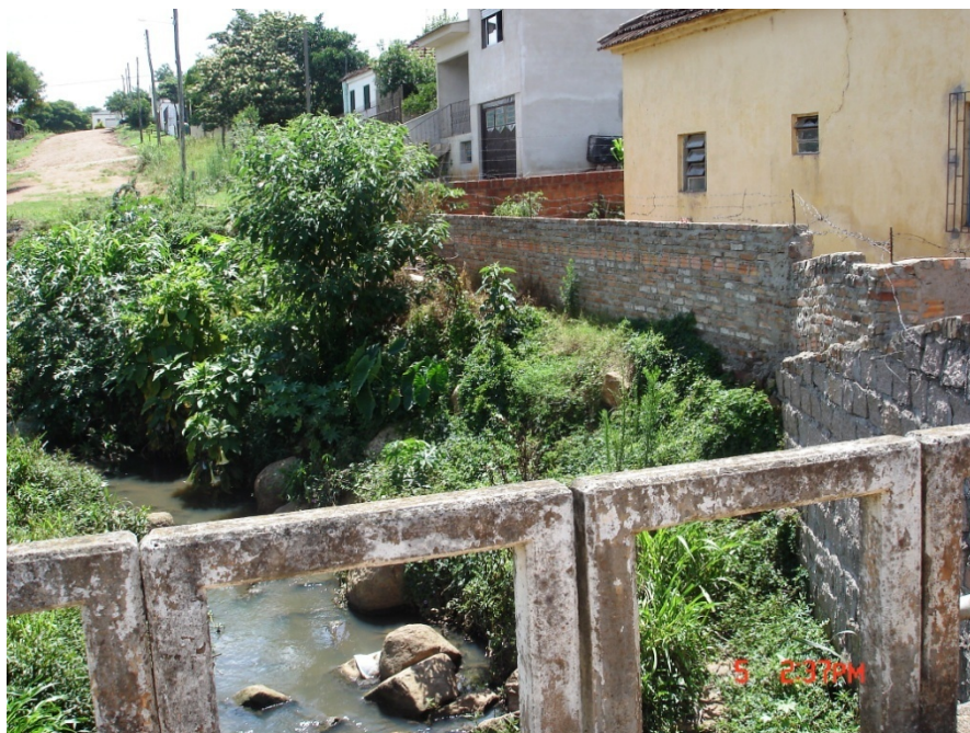
Fotografia 8 – Aspecto da impermeabilização do Lajeado do Moinho ao longo do Bairro Kurtz. Fonte: Trabalho de campo, 2006.
