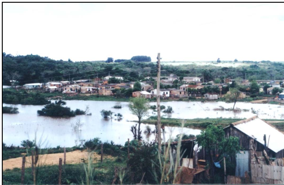
Fotografia 4 - Ocupação da planície aluvial do Rio São Sepé: situação de cheia Fonte: Prefeitura Municipal, 2005
