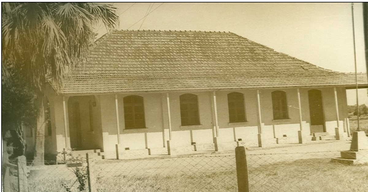
Fotografia 03 – Vista frontal da Escola Municipal de Ensino Fundamental Sete de Setembro. Fonte: Arquivo Histórico – Prefeitura Municipal de Restinga Sêca. Org.: CIROLINI, A., 2008.
