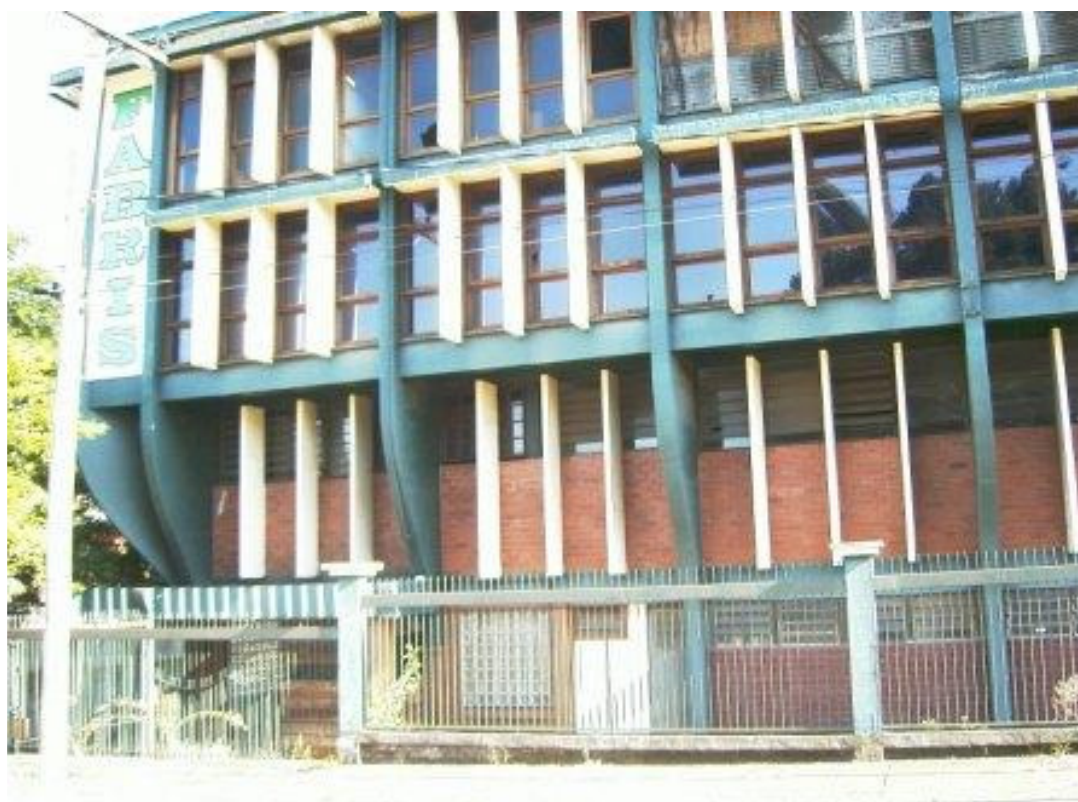
Figura 8 – Prédio de indústria calçadista fechada no bairro São Luis. Detalhe na condição de abandono da estrutura. Fonte: alunos EJA 7 a /8 a
