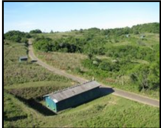
Fotografia 6: Vista parcial dos paióis da (13º Cia DAM)/Itaara/RS
