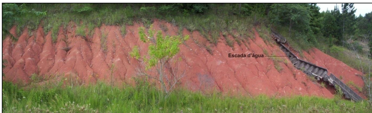
Figura 18 - Processo erosivo desencadeado pela exposição de rochas lamiticas.
