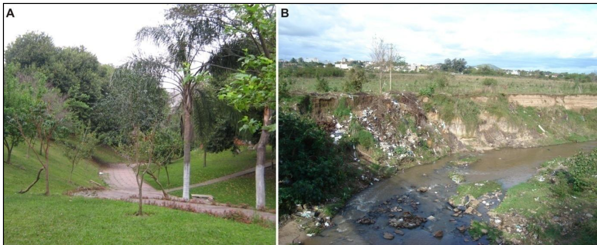
Figura 9 - Intervenções estruturais no Arroio Cadena: A) Canalização fechada do Arroio Itaimbé (Centro). Na área localizada junto ao parque, o canal do referido Arroio foi transformado em passeio público; B) Processo de erosão de margem e alargamento do canal no trecho retificado do Arroio Cadena, na Vila Oliveira. Observa-se, na margem côncava ou de erosão, cicatrizes de escorregamento e depósitos de lixo.
