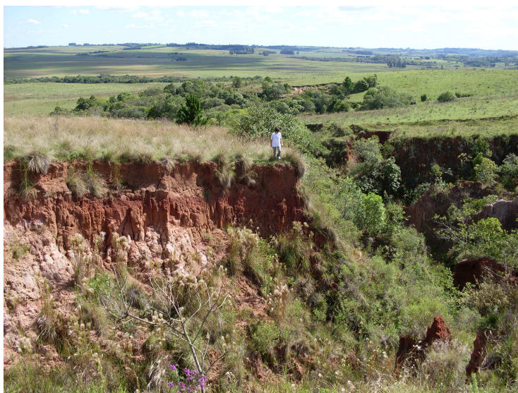
Figura 31 - Presença de vegetação ao longo da área e no interior da voçoroca
