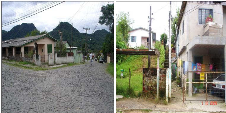
Figura 5 – Rua Armando Ceccin – lado esquerdo Padrão de construção da área regularizada fundiariamente: Casas de alvenaria, umas ocupando todo o terreno; outras, com espaço para jardins. Sendo a maioria produto da auto-construção. (Foto CJSA/2009)
