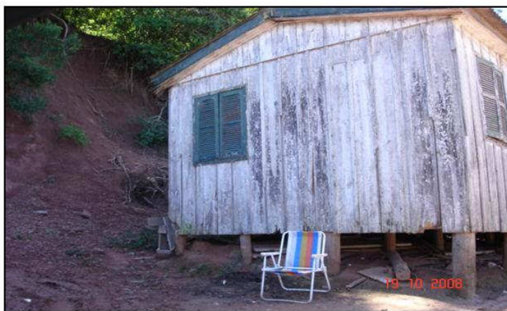
Figura 29 – Sede da Associação Comunitária da Vila Nossa Senhora Aparecida. Destaque para a situação da encosta. (Foto CJS/2008)
