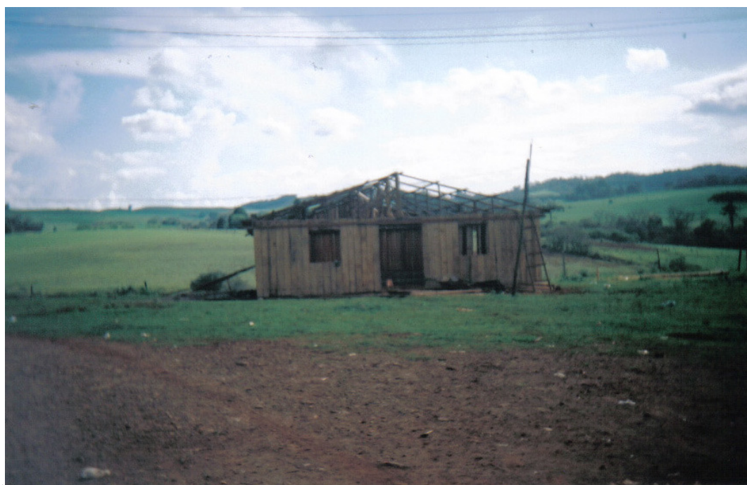
Figura 27 Igreja Evangélica em construção
