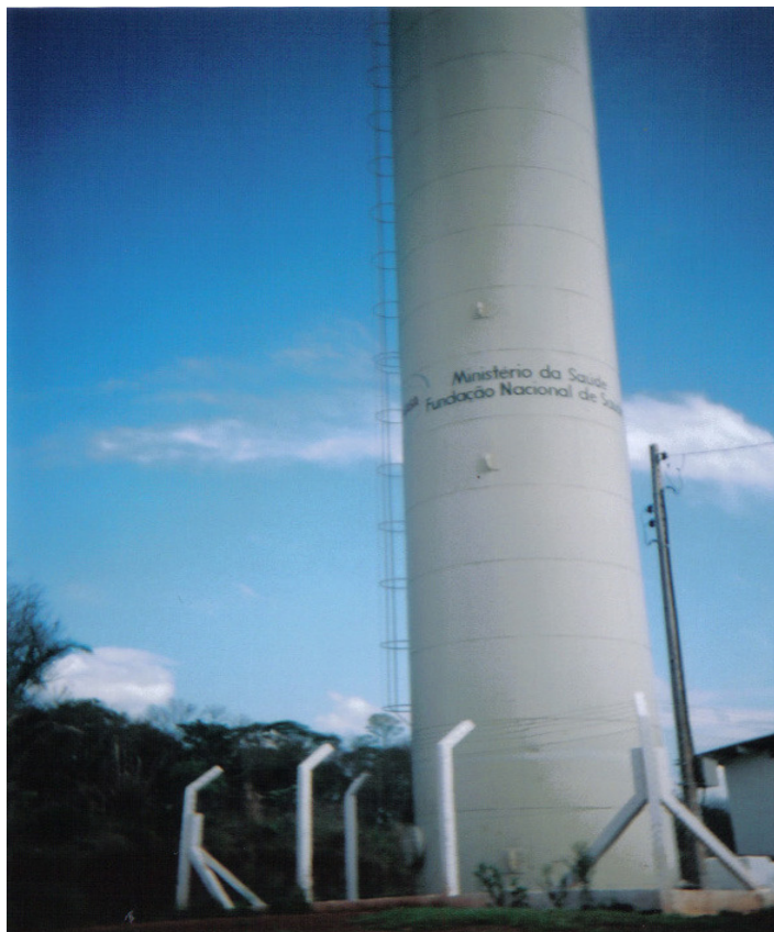
Figura 37 – Reservatório de água para abastecimento da TI Fonte: Autora, 2009.
