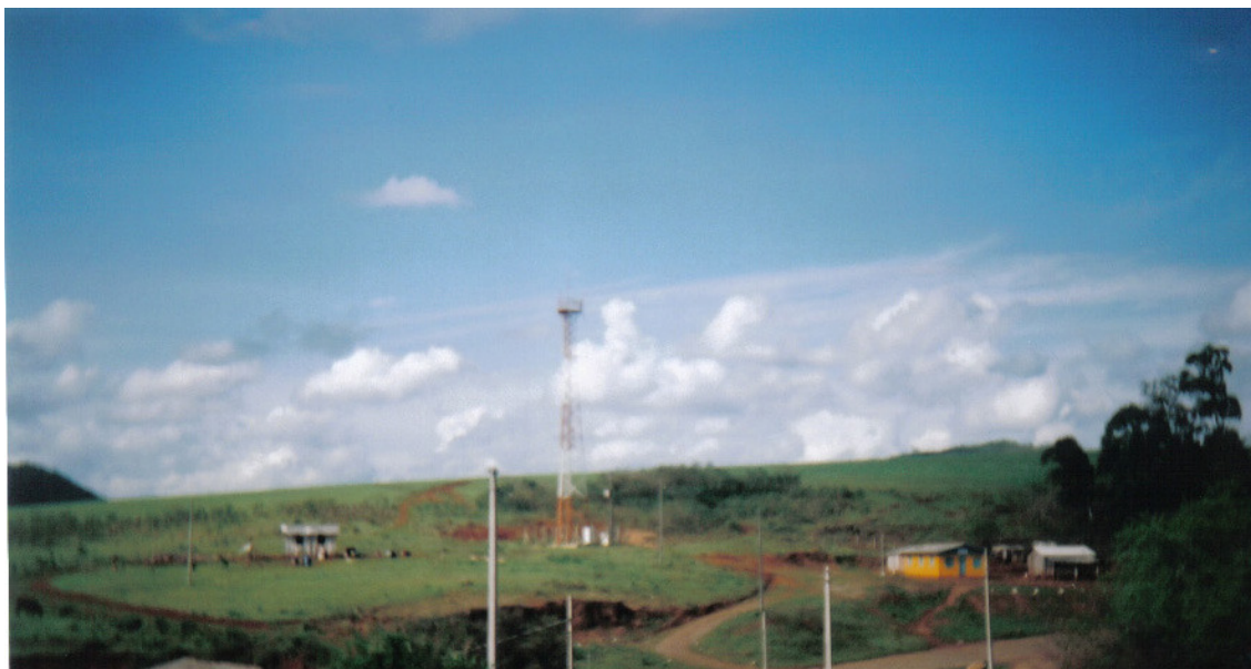
Figura 32 – Torre para telefonia móvel
