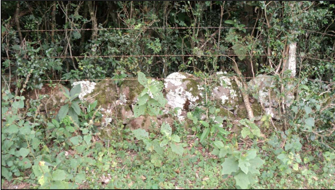
Figura 42: Marcas na paisagem – cercas de pedra. A construção de cercas, utilizando pedras, era uma técnica comum entre os primeiros colonizadores. Utilizavam deste recurso para delimitar espaços para a criação de suínos e bovinos, além de que, com a construção das cercas, retiravam as pedras das áreas de produção. Com a mecanização, as cercas de pedras foram arrancadas e na maioria dos casos as pedras que faziam as cercas foram enterradas em grandes valos. A ação de enterrar pedras foi comum na área de estudo com o intuito de eliminar tudo o que fosse dificultar a mecanização das lavouras, neste caso, as pedras. Atualmente pouco resta desta marca da cultura imigrante, as cercas de pedras.
