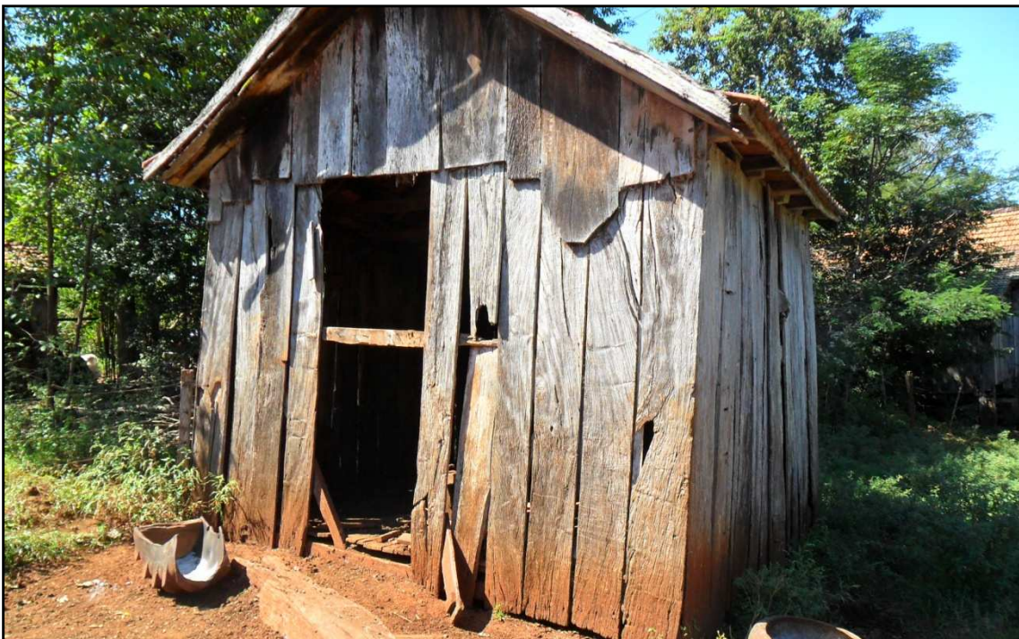
Figura 72: Exemplo do resultado do intenso assoreamento proveniente da erosão pós a mecanização da agricultura na área de estudo. Este pequeno galpão foi construído sobre pilares de aproximadamente 2, 5 metros. Hoje (2011) os 2,5 metros estão soterrados pela terra provenientes das lavouras do entorno.
