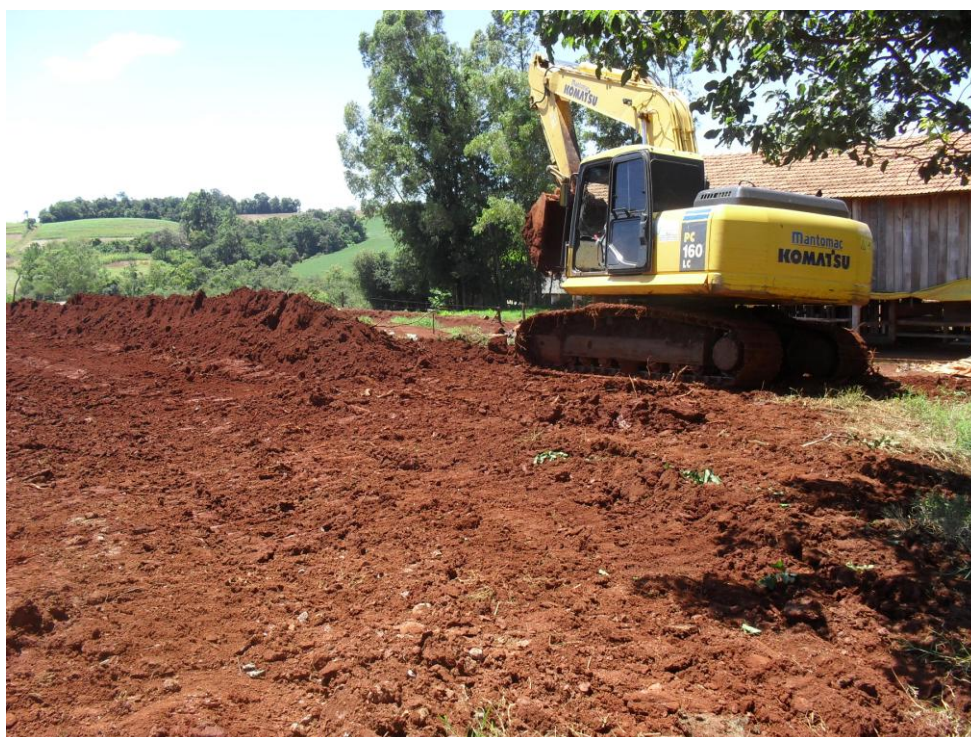
Fotografia 8 – Terraplanagem para construção de chiqueiro, com máquinas da Prefeitura Municipal de Três Passos, RS. Fonte: Trabalho de campo, 2011.
