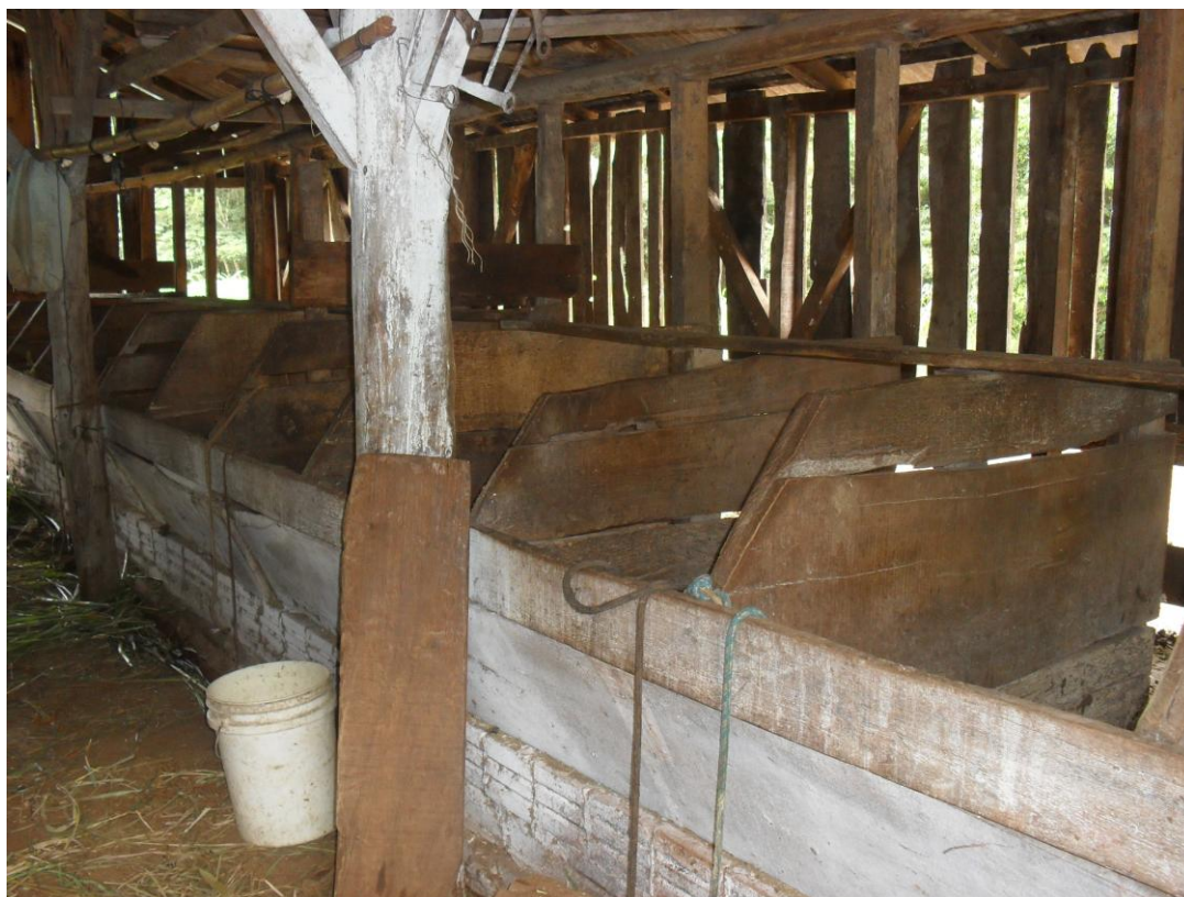
Fotografia 13 – Instalação de antigos chiqueiros. Fonte: Trabalho de campo, 2011.
