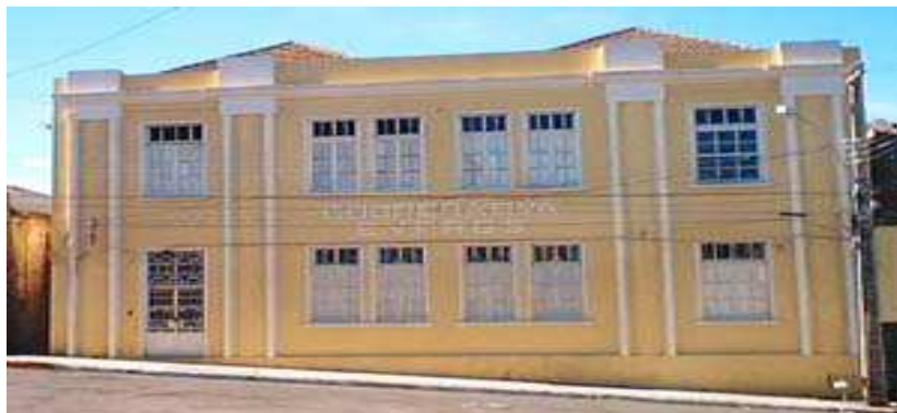
Ilustração 13.: Santa Maria - Edifício da Sede da Cooperativa dos Empregados da Viação Férrea do RS.
