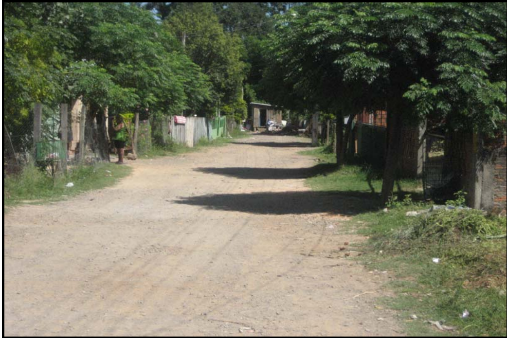
Figura 20 - Rua sem pavimentação na Vila Urlândia Fonte e organização: WERNER, P. V. N.
