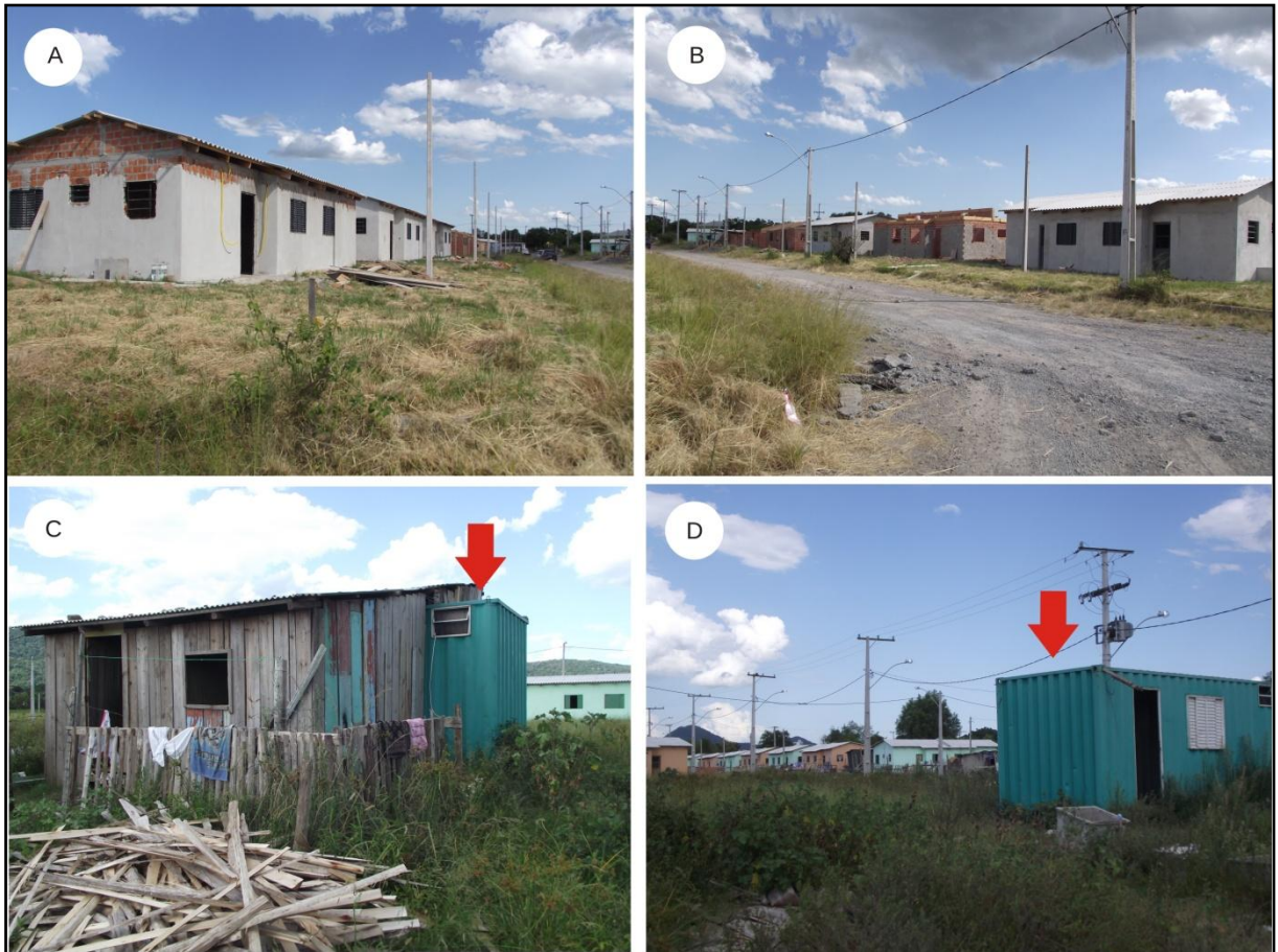
Figura 31 – Loteamento da Vila Brenner, no bairro Divina Providência, onde é possível observar o início da construção das casas populares (Figuras A e B) para reassentamento das famílias que viviam em situação de risco nas margens do Cadena, que foram retiradas para iniciar as obras do PAC. Inicialmente, as famílias foram instaladas em casas-contêineres, apontadas pelas setas vermelhas nas Figuras C e D.
