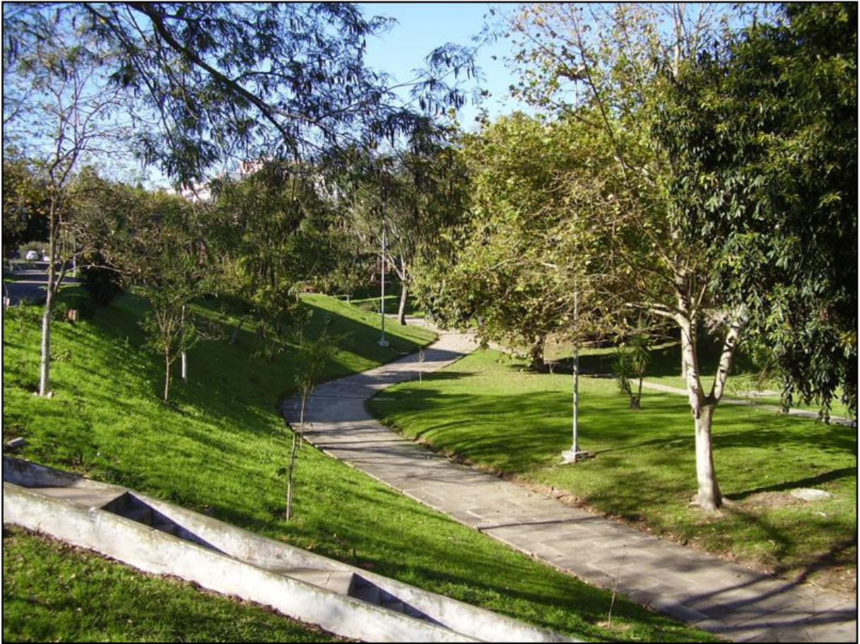
Figura 19 – Parque Itaimbé, onde o único resquício da paisagem original do Arroio Itaimbé é o calçamento que acompanha o traçado do talvegue do arroio canalizado em sua sinuosidade.
