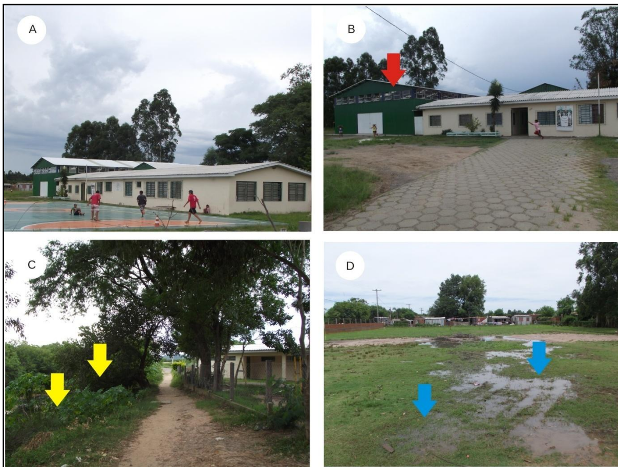
Figura 40 – Área d Escola Municipal Vicente Pallotti, onde o prédio principal é representado pela Figura A. A seta vermelha, indicada na Figura B, representa o Centro de Convivência Pallotti III. As setas amarelas (Figura C) apontam a margem do Arroio Cadena, preocupadamente próxima a cerca que delimita a Escola (à direita); e as setas azuis (D) indicam a umidade do terreno, uma vez que faz parte da várzea de inundação do Arroio Cadena.
