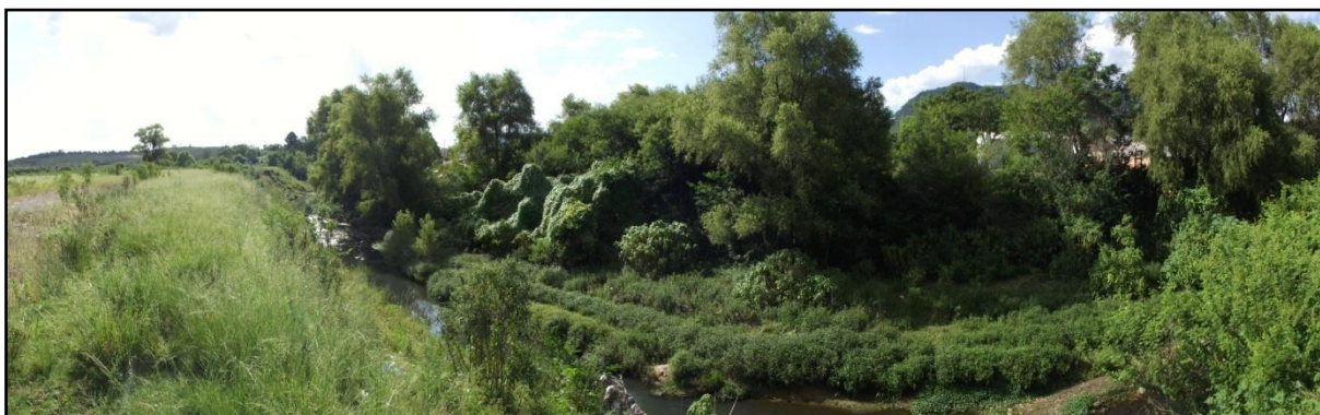
Figura 38 – Canal do Cadena entre a rua José Barin e a rua Fernandes Vieira, mais especificamente no loteamento da Vila Brenner, entre os bairros Caturrita e Divina Providência, onde a Prefeitura Municipal de Santa Maria pretende continuar a obra nos mesmos moldes do PAC, canalizando o trecho e prosseguindo com a avenida.
