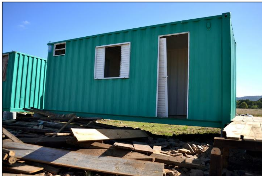
Figura 36 – “Casa contêiner” localizada na Vila Brenner, no Bairro Divina providência, onde desde o dia 7 de setembro de 2010 famílias vivem em “moradias temporárias”. Fonte: O Viés, 2011. 9
