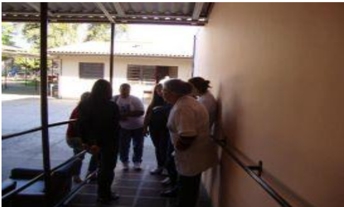
Figura 6- Rampa de acesso aos quartos.
