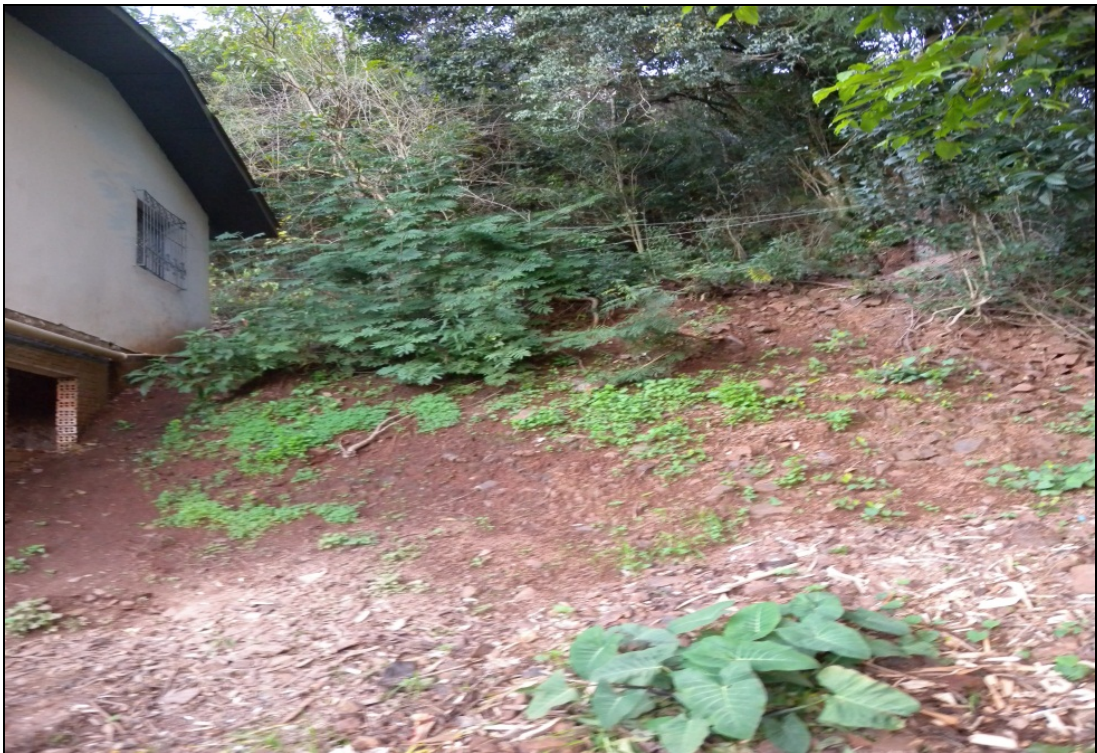
Figura 24 - Vertente íngreme onde se vê na base rocha alterada coberta por colúvio em casa vizinha ao escorregamento. Fotografia: Andrea Nummer (2013)
