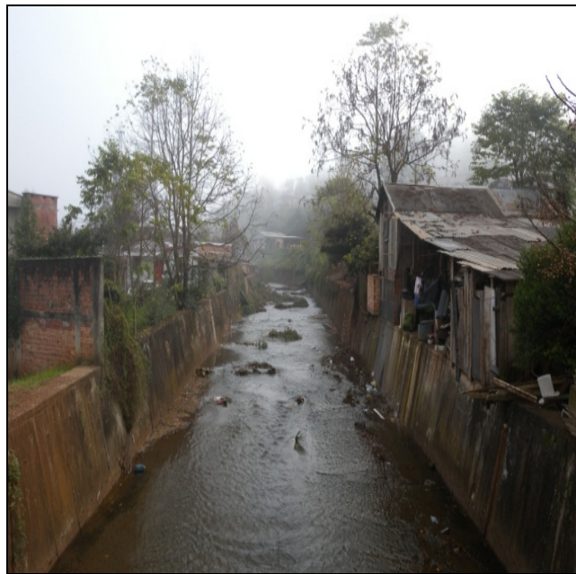
Figura 29 - Arroio Tigre em seu trecho canalizado, bairro Progresso, Erechim/RS. Fotografia: Vanessa Peretti (2013)
