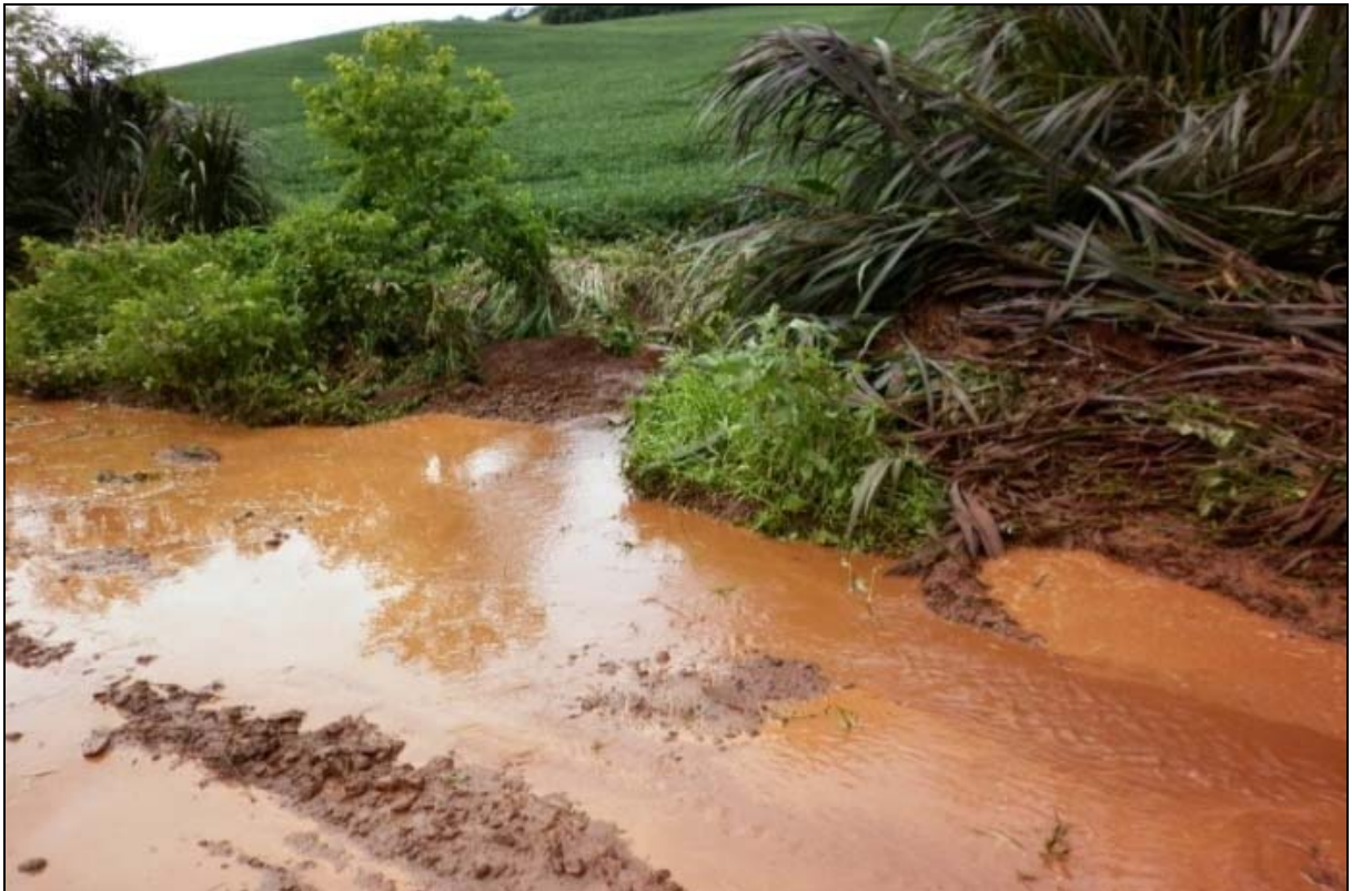
Figura 26 - Enxurrada no Km 14 – Dourado, distrito de Erechim. Fonte: Prefeitura Municipal de Erechim (2011)
