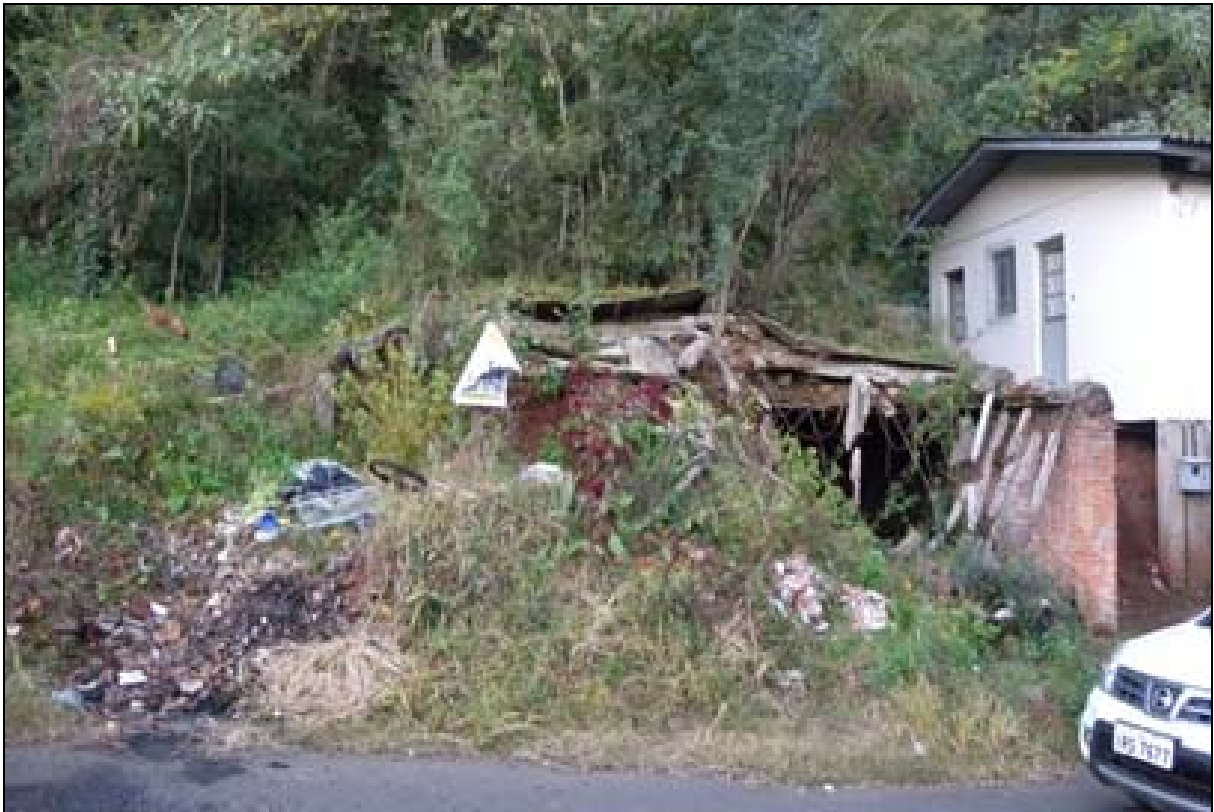
Figura 22 - Foto atual do local do deslizamento ocorrido em 1996 na Rua João Tubin, Bairro Esperança Fotografia: Vanessa A. Peretti (2013).
