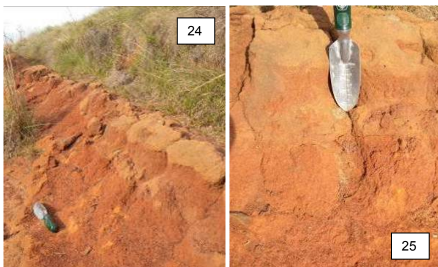
Figura 24 e 25: Formação de capa de compactação.
