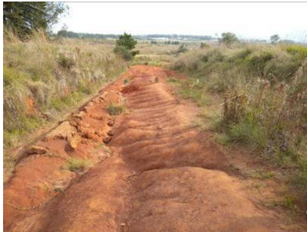
Figura 22: Ponto 3, visão de E3 em direção à E1. Rampa NW.
