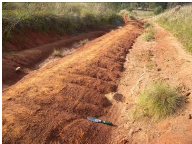
Figura 41: Deposição de areia nos canais principais, da estrada
