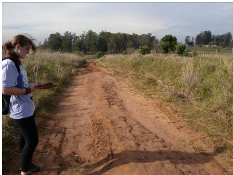
Figura 37: Topo do terraço. Formação de sulcos, devido à passagem de veículos.
