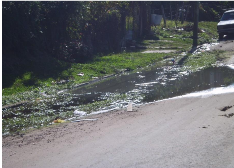
Figura 13 – Esgoto a céu aberto, decorrente de canos entupidos.
