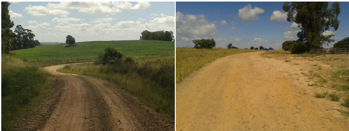
Figura 16 – Estradas de acesso à E.M.E.F. Mascarenhas de Moraes
