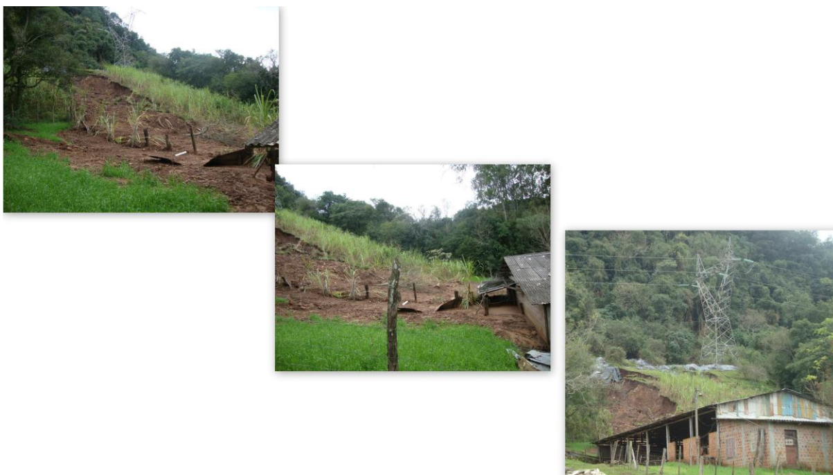
Figura 31: Construção atingida por movimento de massa, do tipo fluxo de terra. Org, Vargas, L.
