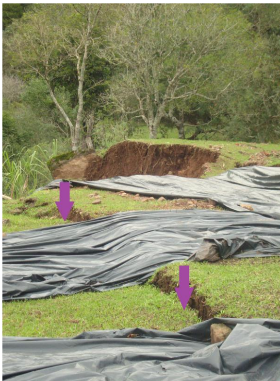
Figura 30: Movimento de massa, próximo a torre de transmissão de energia. Org, Vargas, L.
