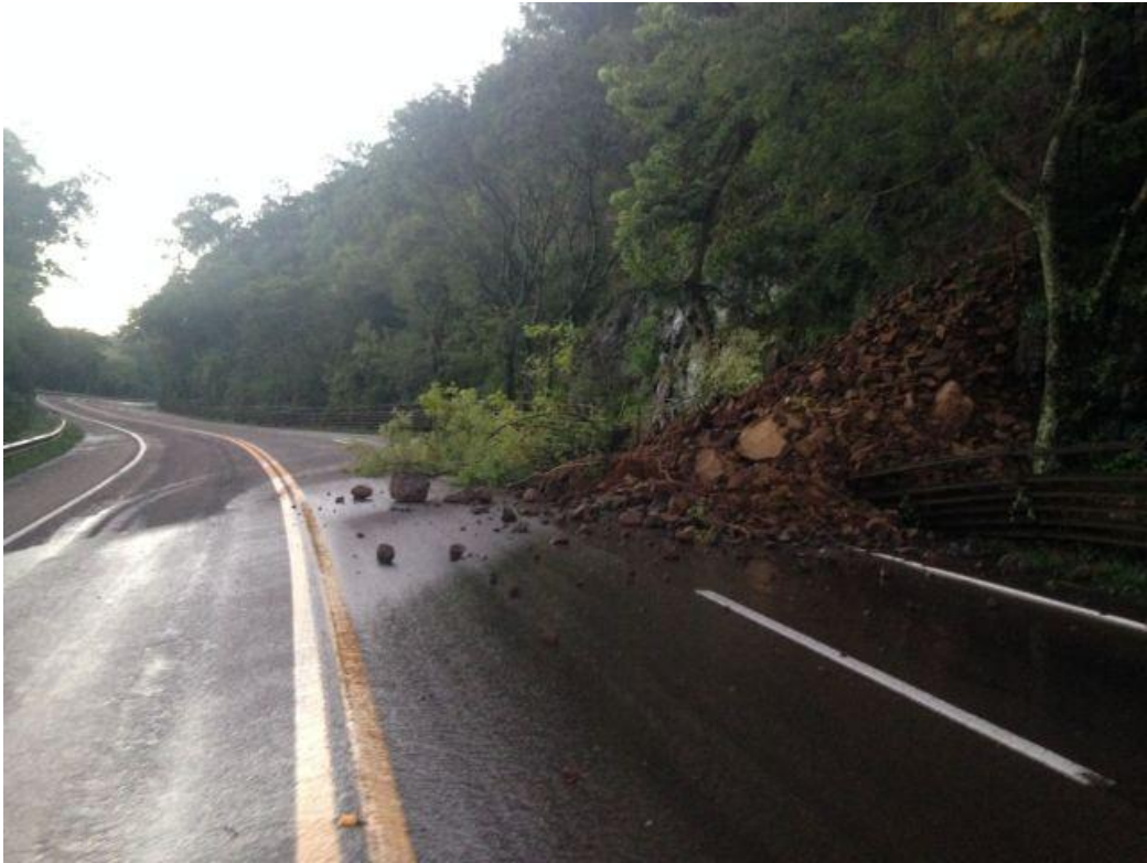
Figura 41: Queda de blocos. Fonte: Click RBS.
