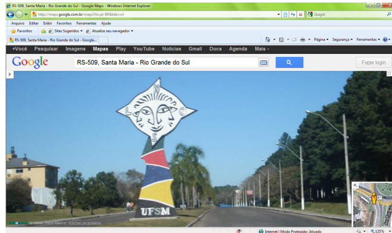
Figura 2 – Parte da Avenida Roraima, Santa Maria/RS, com Google Street View
