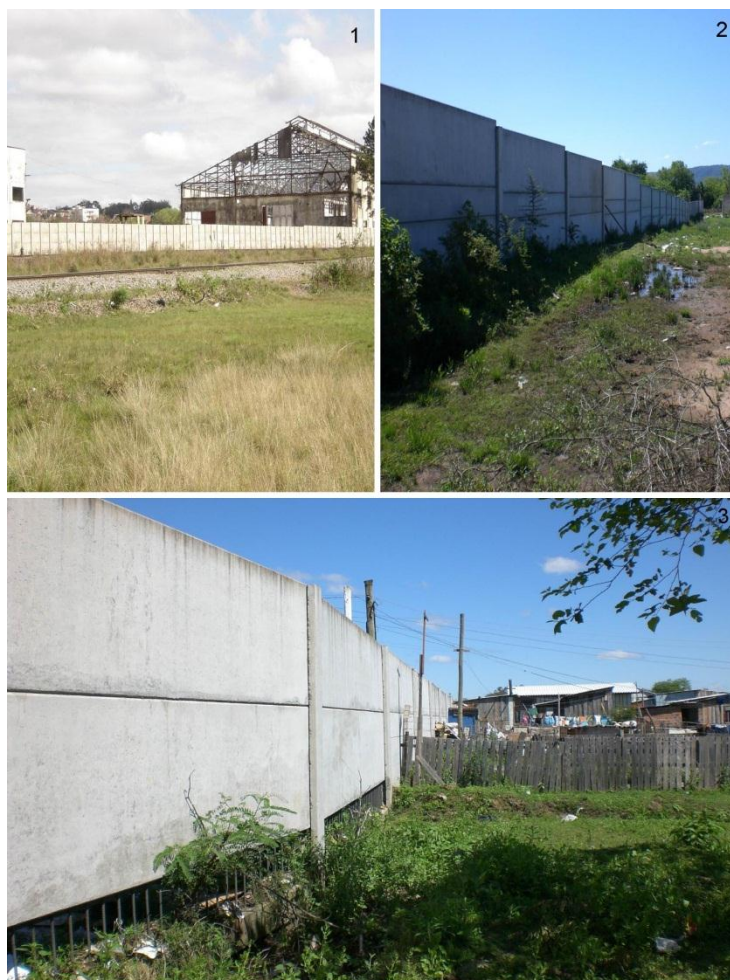
Figura 20- Muros que separam a cidade: 1 no Km3, Muro construído pela ALL empresa arrendatária da ferrovia; 2 e 3 muros que separam a Vila Noal da Vila Natal. Fonte: Rocha, 2011.
