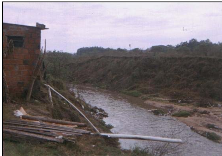
Figura 30 – Lançamento de esgoto de forma in natura entre os pontos 6 e 7 na sub-bacia hidrográfica do Arroio Cadena.
