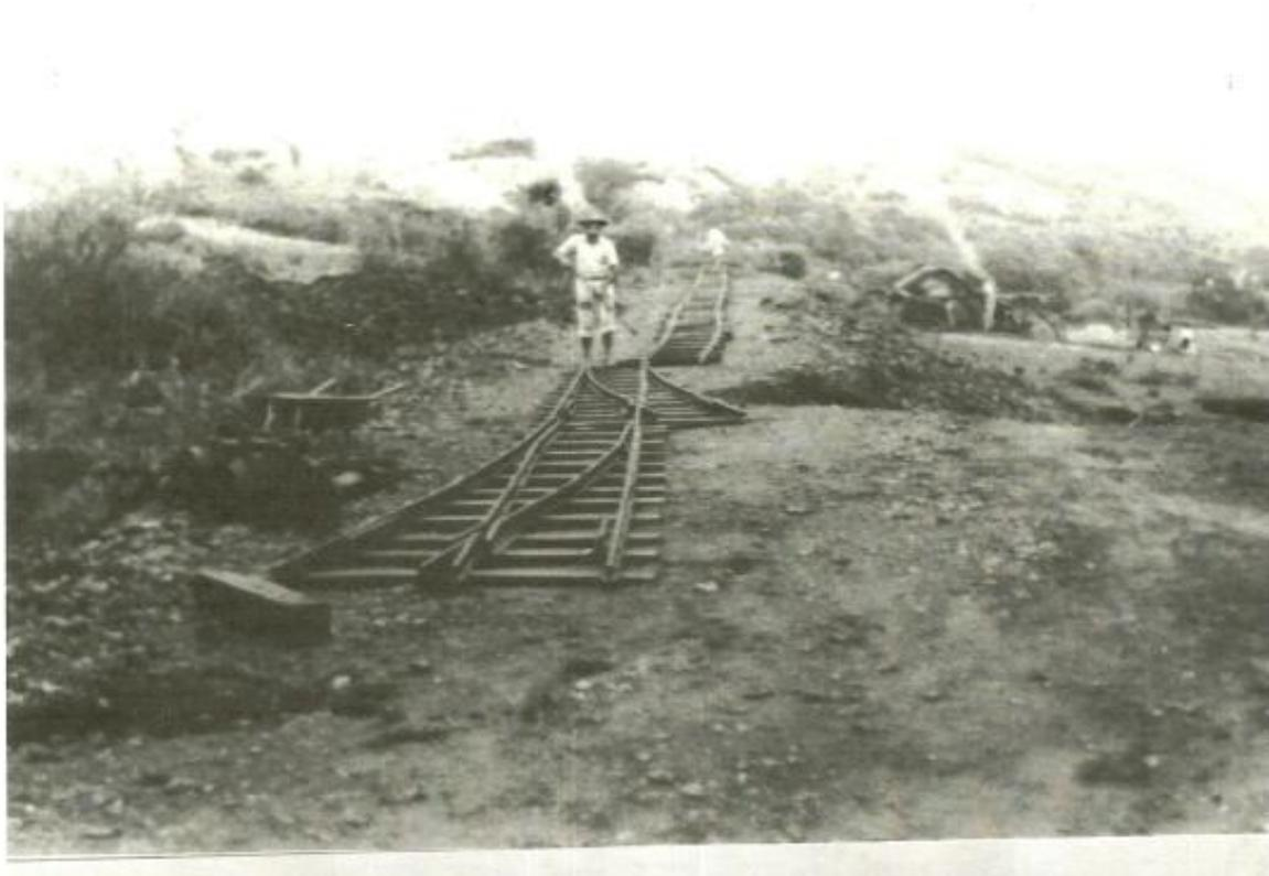
Figura 5 - Estruturação dos trilhos para as vagonetas manuais
